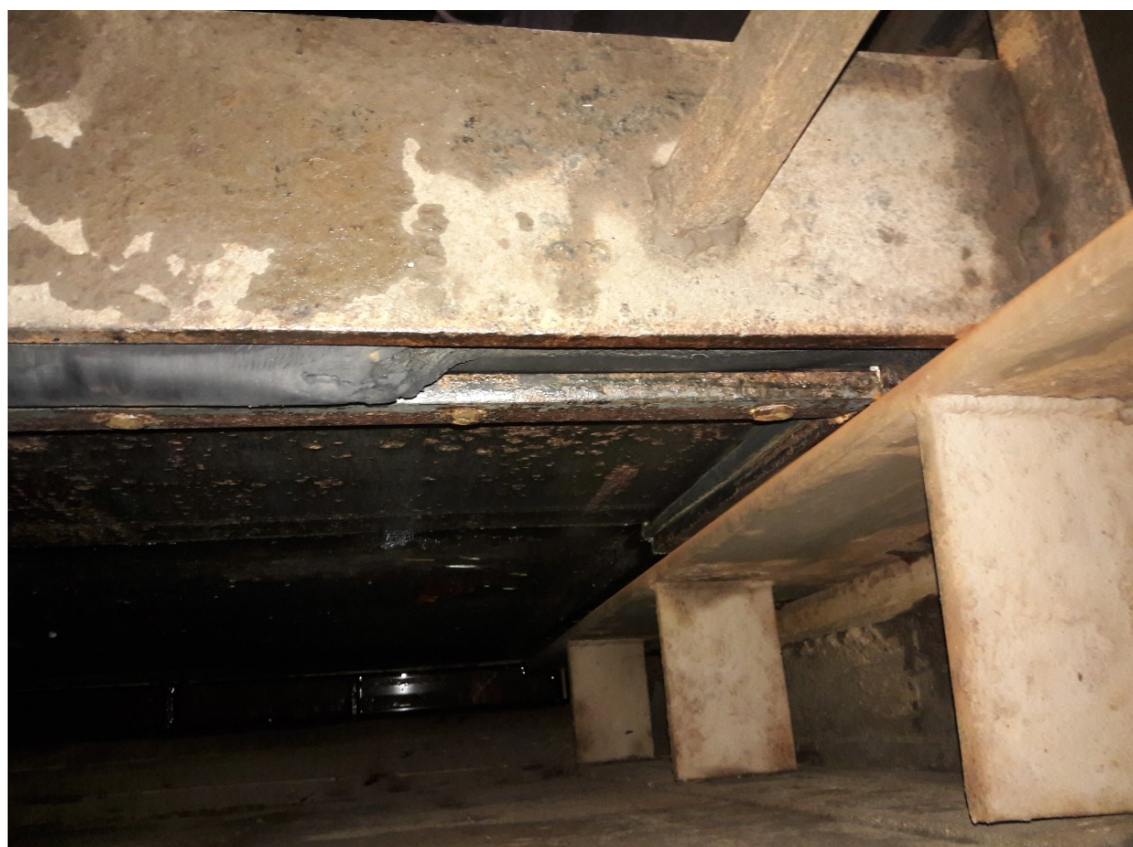
PK Pardubice, vypouštěcí stavitko – poškozené těsnění
