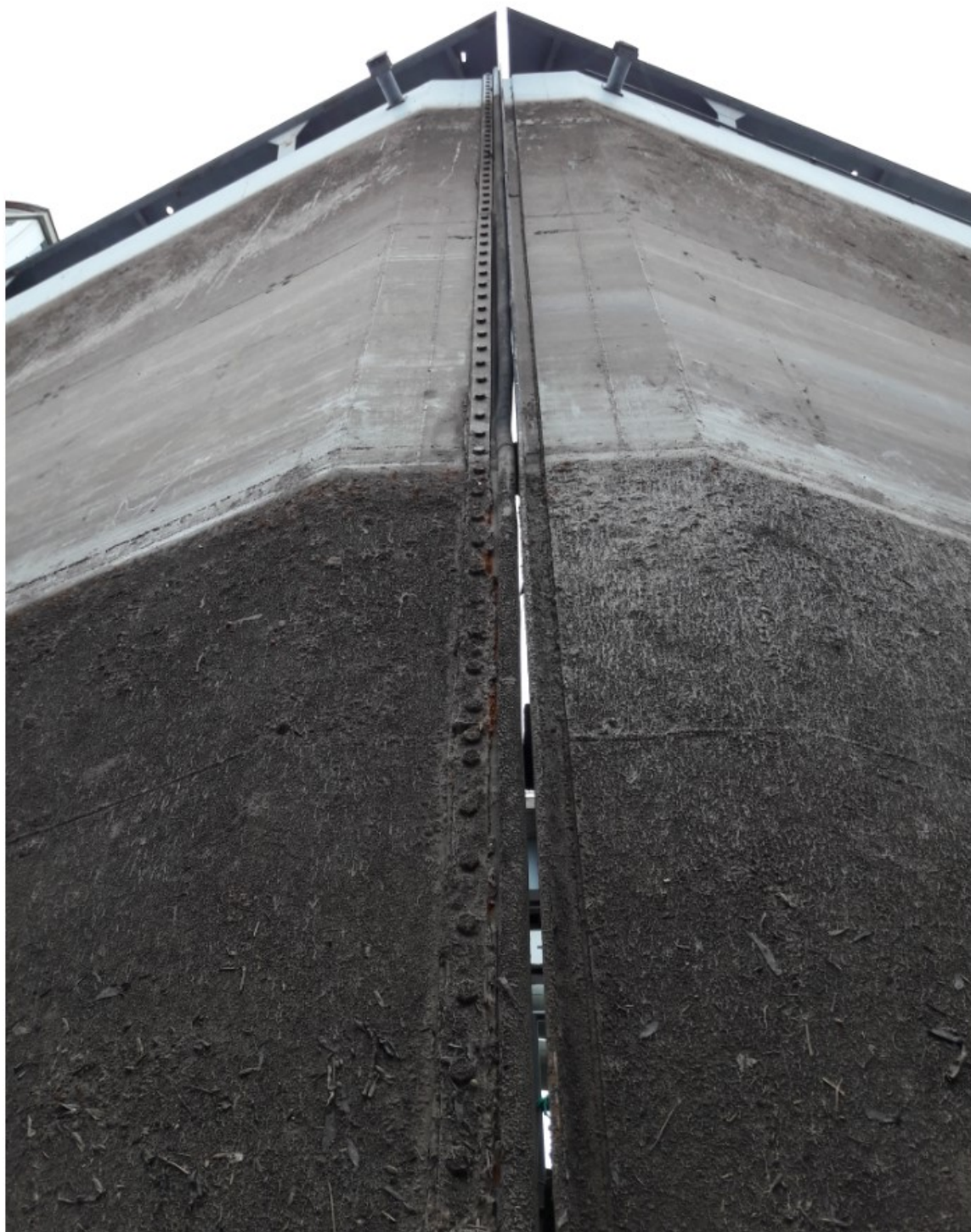
PK Pardubice, vzpěrná vrata – srazové těsnění
