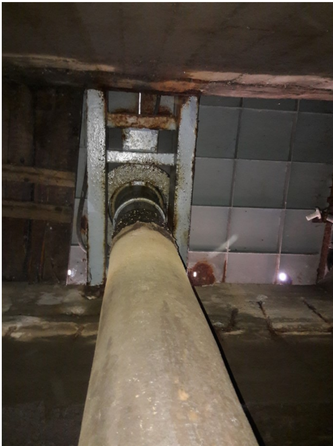
PK Pardubice, hydropohon vypouštěcího stavítka - ukotvení
